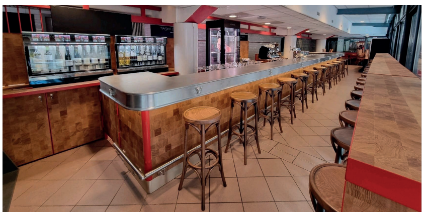
Fabrication et pose d'agencement sur mesure, Maison Louchebem, Toulouse
